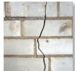
Za premoštavanje dinamičkih pukotina i za dodatno mehaničko pojačanje preporučamo kombinaciju Murfill vodootpornih premaza sa Murfill membranama (pletanim ili nepletanim)
